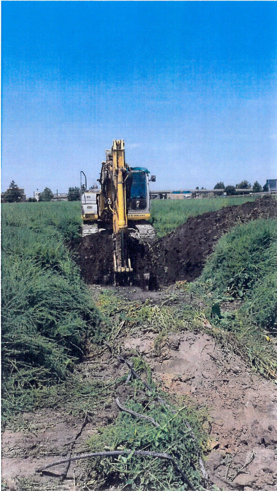
F.9. – Movimentazione del terreno per la trincea esplorativa TAMP-TRENCH_4.
