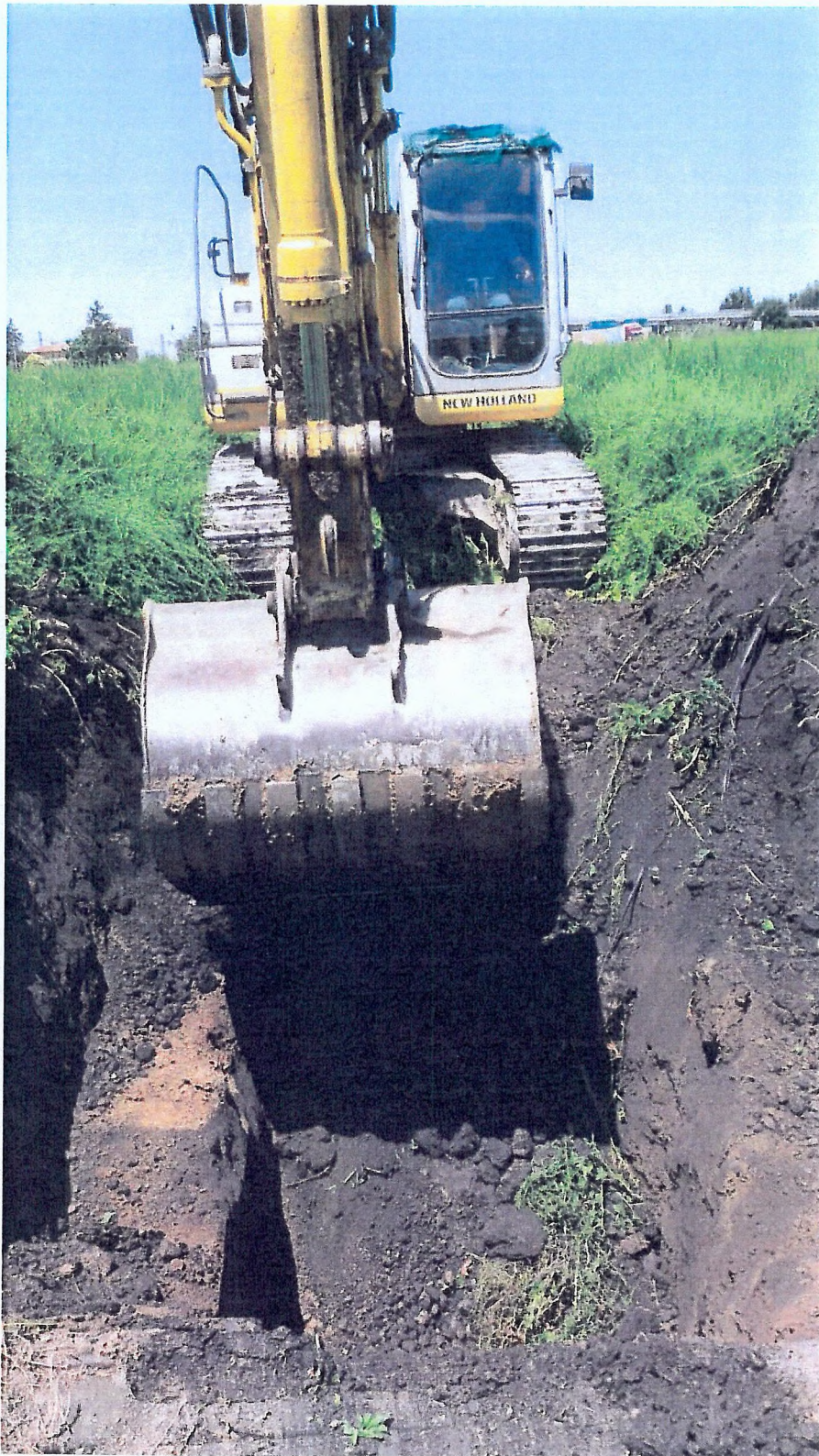
F.10. – Movimentazione del terreno per la trincea esplorativa TAMP-TRENCH_4.
