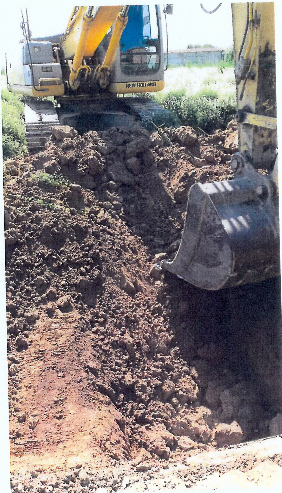
F.5. – Movimentazione del terreno per la trincea esplorativa TAMP-TRENCH_2.
