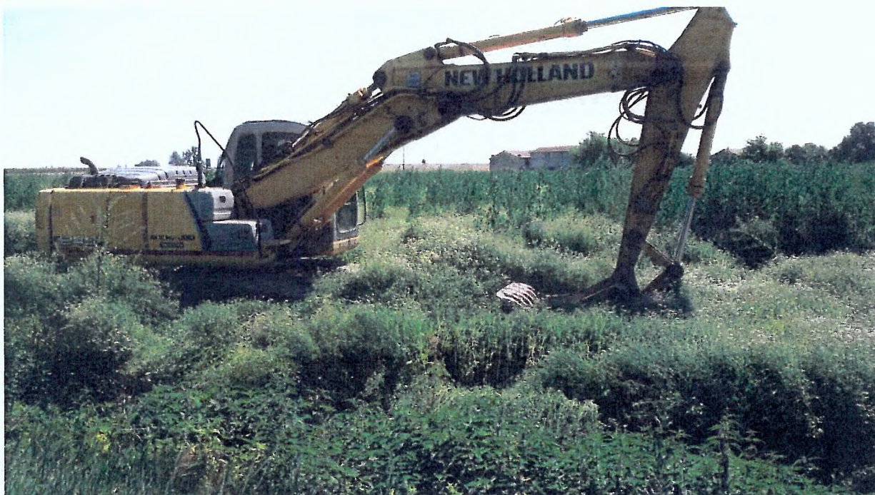
F.1. – Movimentazione del terreno per la trincea esplorativa TAMP-TRENCH_1.
