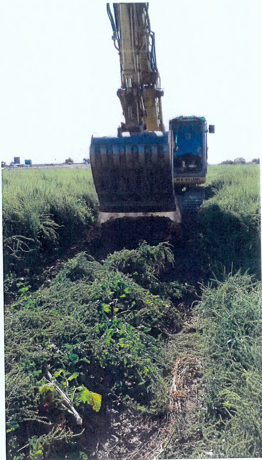
F.7. – Movimentazione del terreno per la trincea esplorativa TAMP-TRENCH_3.
