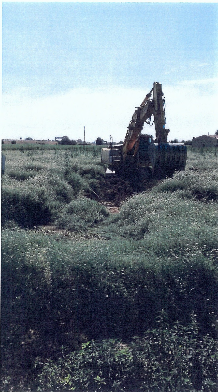
F.4. – Movimentazione del terreno per la trincea esplorativa TAMP-TRENCH_2.
